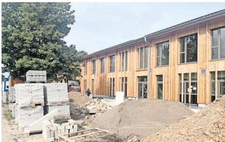
Hinter der Holzfassade der neuen Grundschule Groß Düngen wird noch voraussichtlich bis Mitte Dezember gearbeitet. FOTO: THOMAS WEDIG
