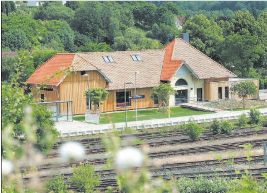
In Bad Salzdetfurth erstrahlt das alte Bahnhofsgebäude in neuem Glanz. Ein großer Teil der Baukosten ist aus dem „Proland“-Förderprogramm bezahlt worden. Foto: Archiv
