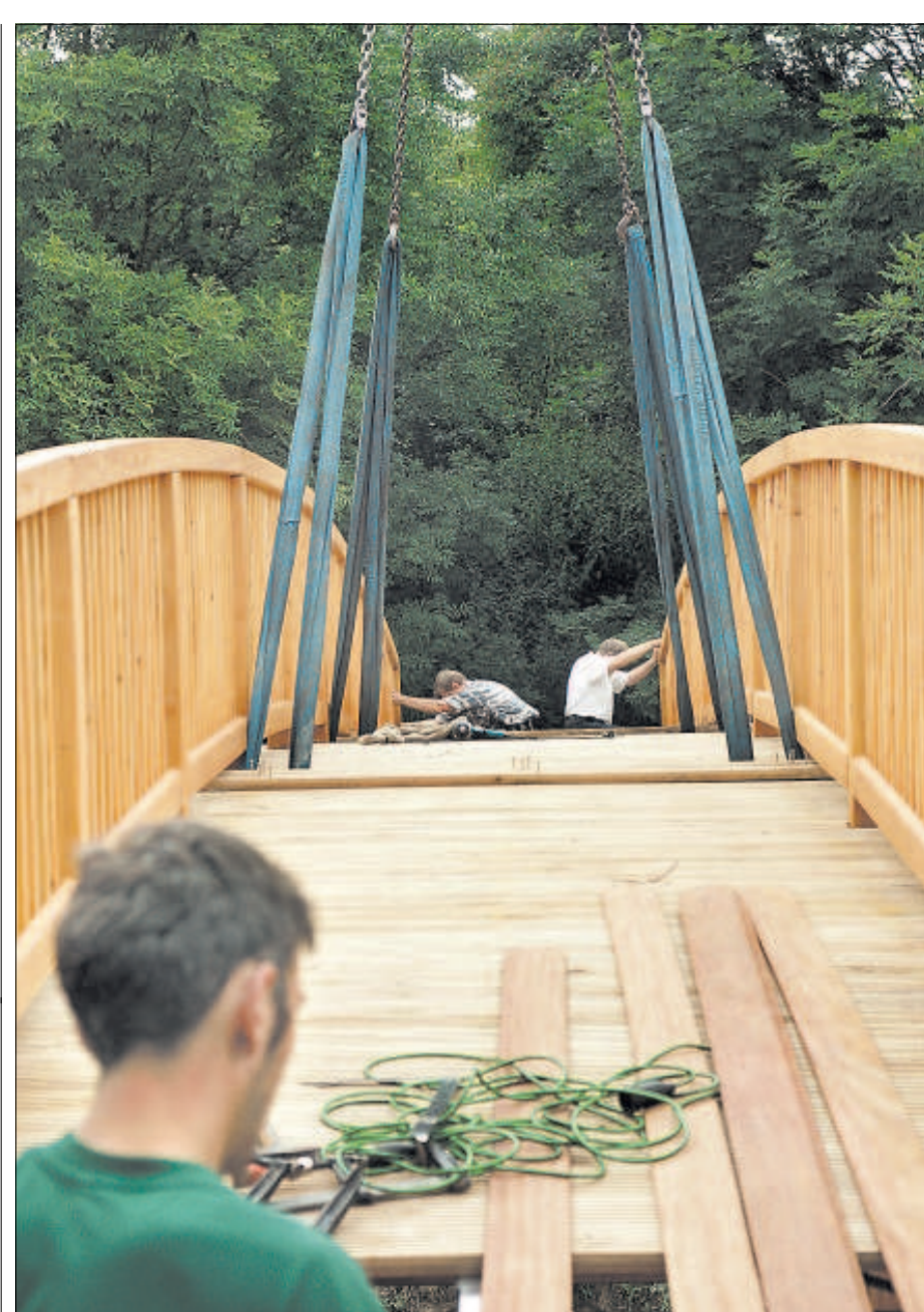
Vier Gurte halten die neun Tonnen schwere Holzkonstruktion in der Schwebe. Zimmerleute setzen sie millimetergenau auf die beiden Stützböcke links und rechts der Innerste.
