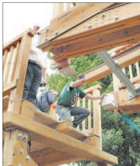
Zentimeter um Zentimeter senkt sich die Brücke herab. Zimmermann Jens Winkel achtet darauf, dass die stählernen Anschlusswinkel auf die Bohrungen im Querbalken passen.
