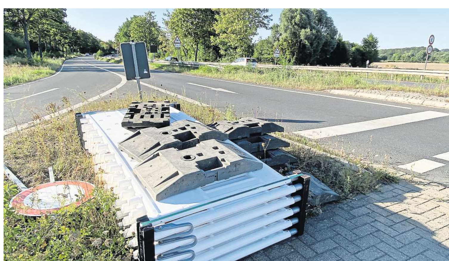
Die Absperrbaken liegen schon bereit: In der kommenden Woche wird die Bundesstraße 243 von Ochtersum Richtung Hildesheim gesperrt.
