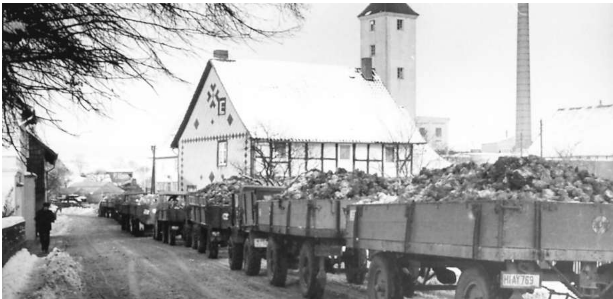
1965 behinderte ein besonders früher Kälteeinbruch die Arbeiten massiv, es wurde sogar eine Unterbrechung der Saison erwogen. Alles, was an Rüben schon geerntet und in nun schneebedeckten Mieten eingelagert worden war, wurde im Eiltempo zur Weiterverarbeitung gekarrt. Auch vor der Zuckerfabrik in Groß Dungen stauten sich am 25. November die Schlepper bis zur Bundesstraße zurück.
